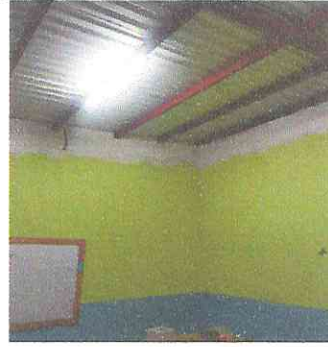
foto 4 Instalación de iluminación nueva
