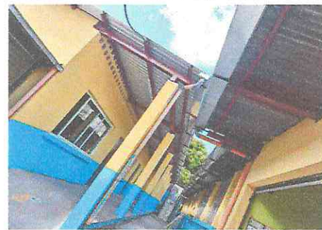
foto 6 Montaje de canales ya existentes
