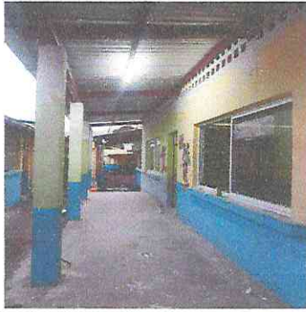
foto 1 instalación de ventanas PVC
