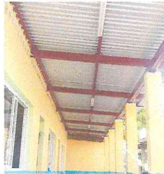
foto 2 pintura de estructura y paredes
